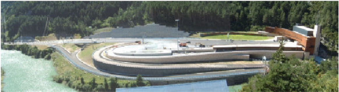
Vista de la boca española del túnel de Somport y sus accesos
