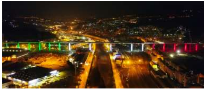
Ponte «Per Genova»
