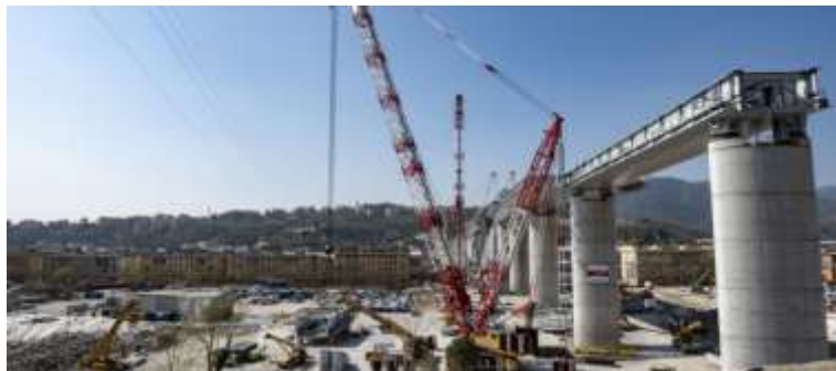
Ponte «Per Genova»
